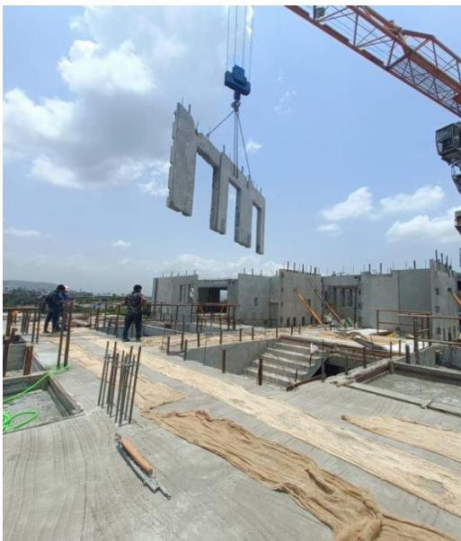
Fig 13 .Erection 1
